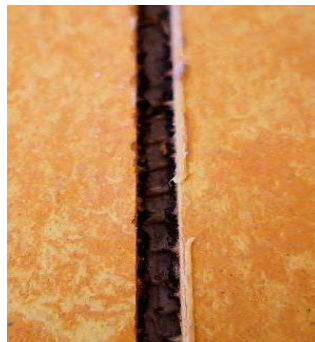
Keine Fräsung keine Haftung
