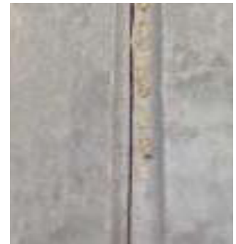
Fräsung außermittig schlechte Haftung
